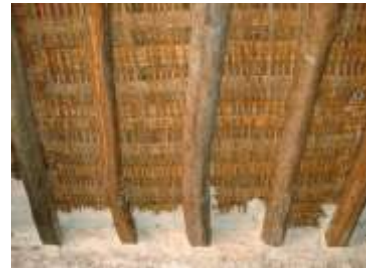
Ramas de chopo cabeceros empleadas como vigas.
